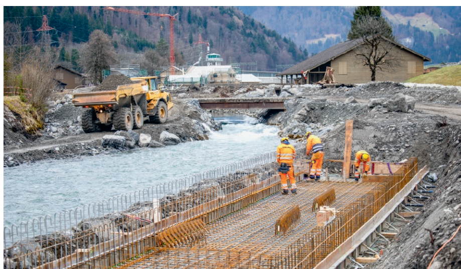
Bau Entlastungsbauwerk Teilprojekt 3
