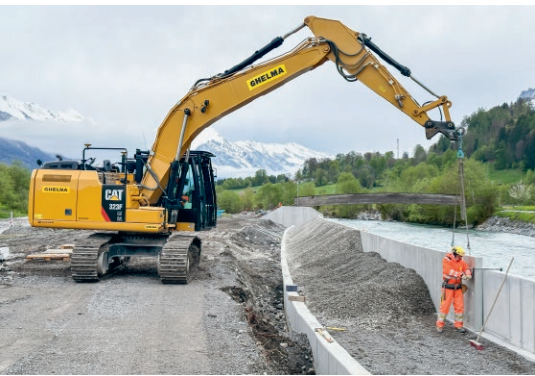
Bau Entlastungsbauwerk Teilprojekt 3
