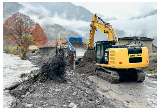
Schüttung Notdämme bei Hochwasser Teilprojekt 3
