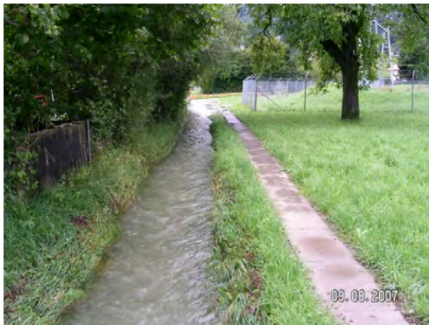
Abbildung 3 Überlaufgraben vom Versickerungsbecken in den Versickerungsweiher Stampach Aufnahme vom 09. August 2007, Abfluss Q = \text{max. } 700 - 800 \text{ l/s}
