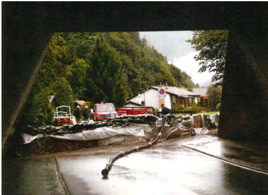
Abbildung 1 Aufwändige Abwehrmassnahmen bei der Unterführung Rugenstrasse in Matten Aufnahme vom 09.08.2007
