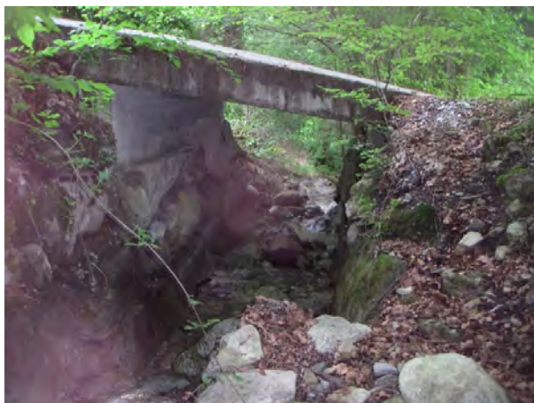
Abbildung 4 Die bestehende Brücke im Gubi (zu kleiner Querschnitt B = 1.20 \text{ m} / H = 1.60 \text{ m} )
