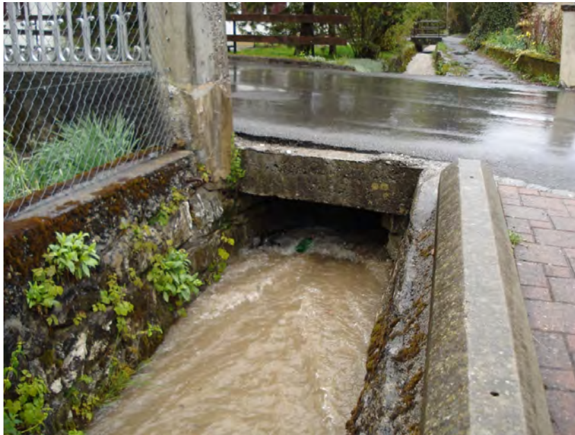
Abbildung 2 Der Stampach während des Hochwasserereignisses vom 21./22. April 2008. Standort: Unspunnenstrasse, Blickrichtung bachabwärts (HQ = ca. 0.5 - 0.7 m 3 /s)
