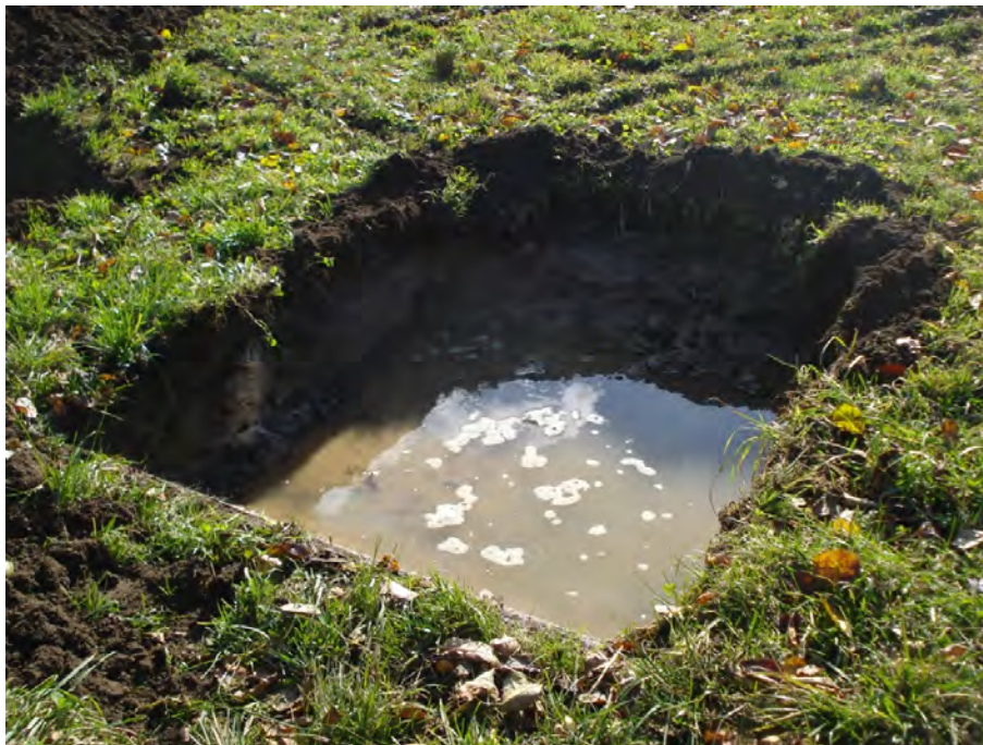
Abbildung 8 Baggerschlitz und Versickerungsversuch (12.11.2009)
